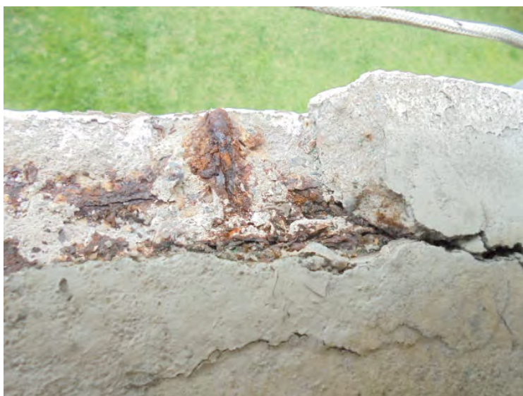
Foto nr. 15: Gulv 4. Opphugning i risset og bommen på forrige foto viser korrodert armering, både tversgående og langsgående armering. Vi ser den tversgående armeringsenden har liten overdekning mot dekkeforkanten. Denne type korrosjon indikerer klorider i betongen og det ble bekreftet ved analysene.
