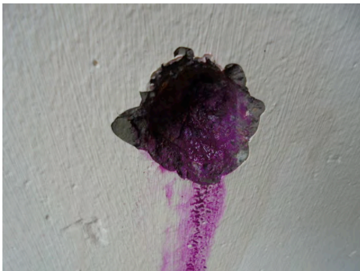
Foto nr. 13: Skillevegg 3. Påsprøyting av pH indikator phenolphtalein i borehullet til kloridprøven gir rød farge der betongen er "frisk" og ikke karbonatisert.
