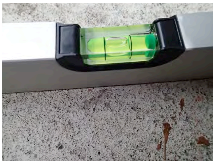
Foto nr. 3: Gulv 1. Dette balkonggulvet har tilnærmet ikke fall mot dekkeforkanten. Men det har et mindre område innerst mot vegg som mulig har litt motfall.
