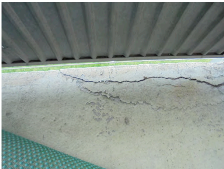
Foto nr. 14: Gulv 4. I ytre del mot dekkeforkanten er det et stort riss med bom i betongen.
