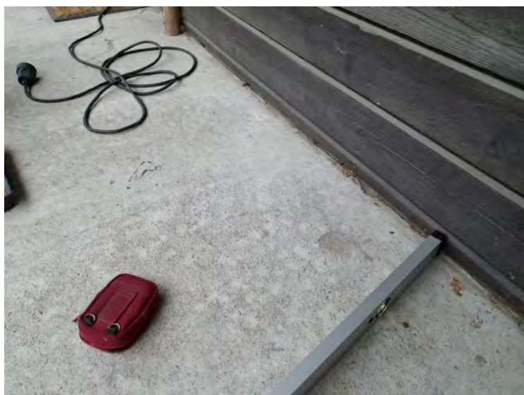
Foto nr. 2: Gulv 1. Balkonggulvet har ubehandlet overflate. Fall forholdene på alle gulvene blir kontrollert med vater.
