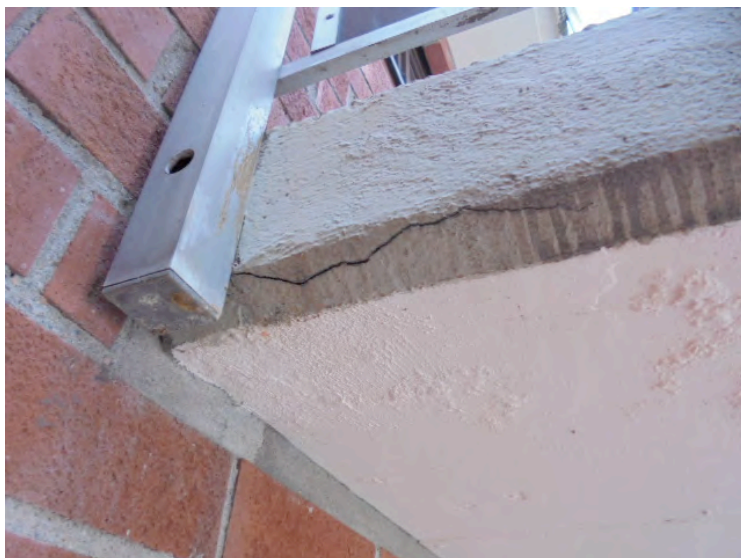
Foto nr. 10: Gulv 2, underside. I ytre del av taket på undersiden av balkongdekket er det riss og bom i betongen
