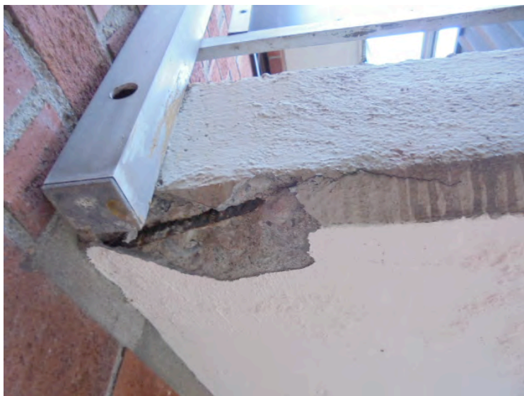
Foto nr. 11 Gulv 2, underside. Opphugning i risset med bom på forrige foto viser korrodert armering.
