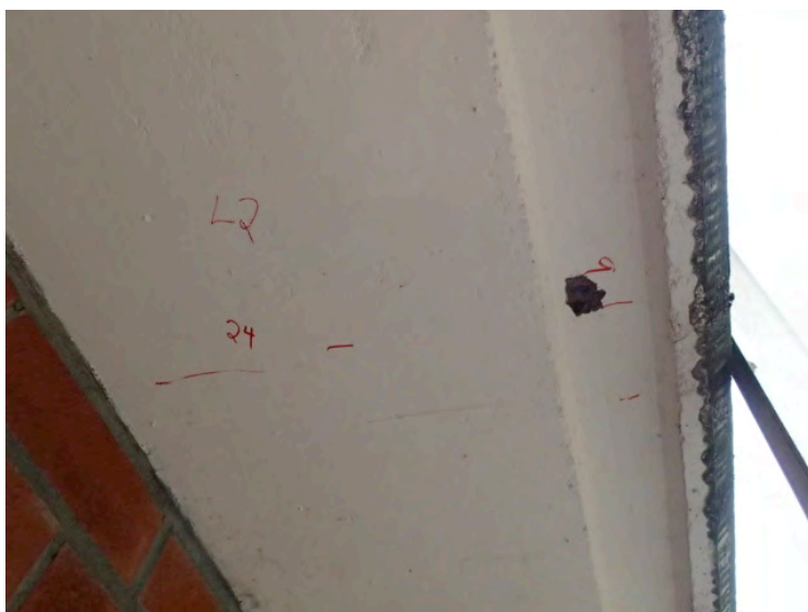
Foto nr. 12: Tak 2. Innmåling av armering i taket viser at overdekningen er lavere i den brede drypprillen i ytre del av taket. Det oppmerkede armeringsjernet har overdekning 24 mm midt i taket og 9 mm i drypprillen. Opphugning i drypprillen viste ren armering.
